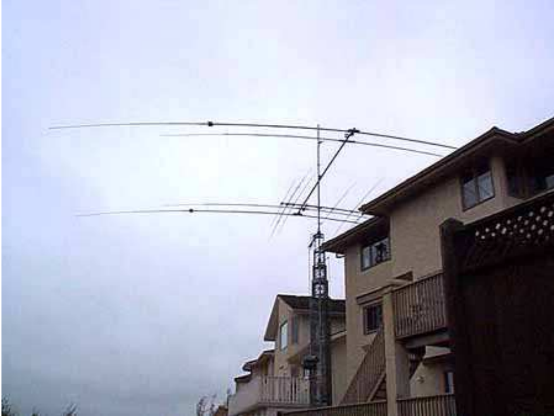
As duas antenas ( 80m e 40m ) na torre telescópica no QTH de VE6WZ ( observe que está na altura mínima , quase rente ao telhado...hi )
